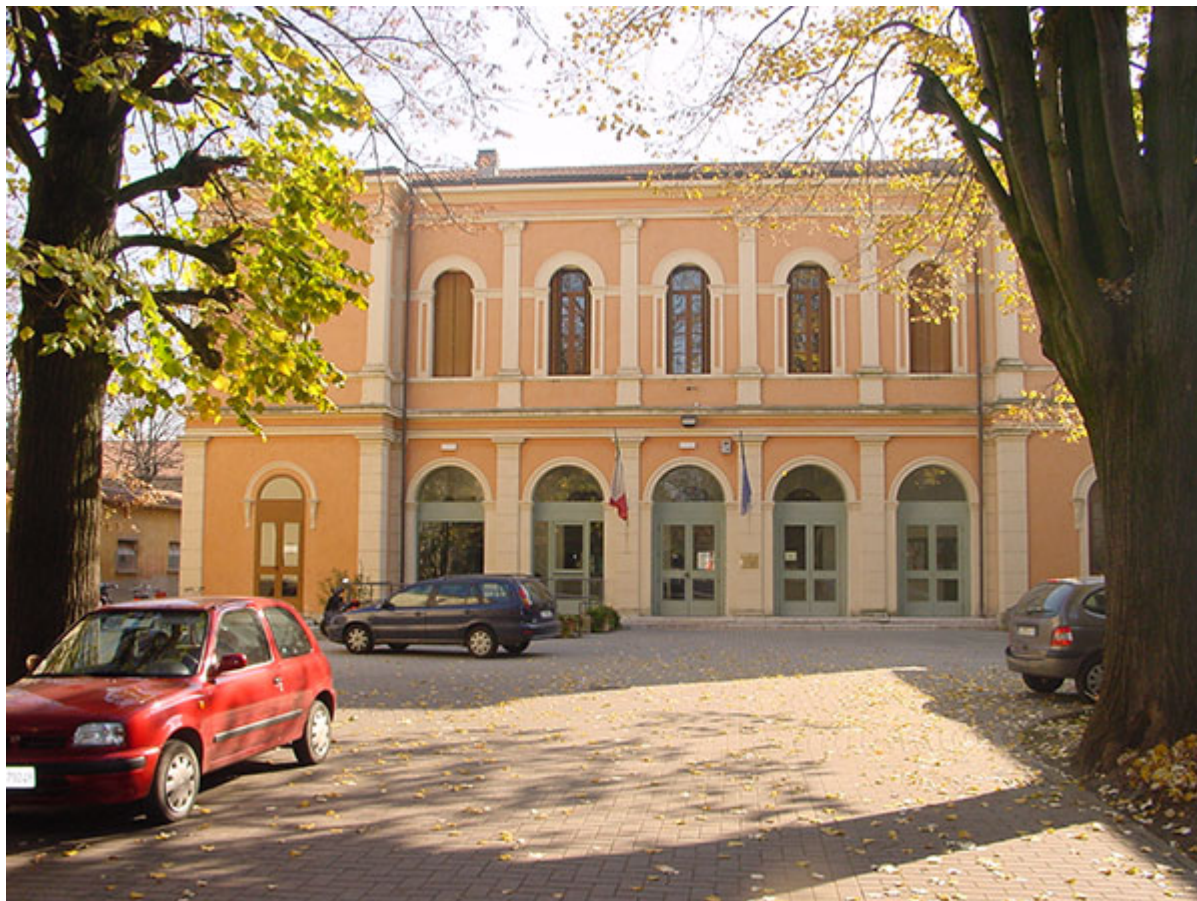
l'ingresso alla nuova ala del Manzoni ora Biblioteca comunale
